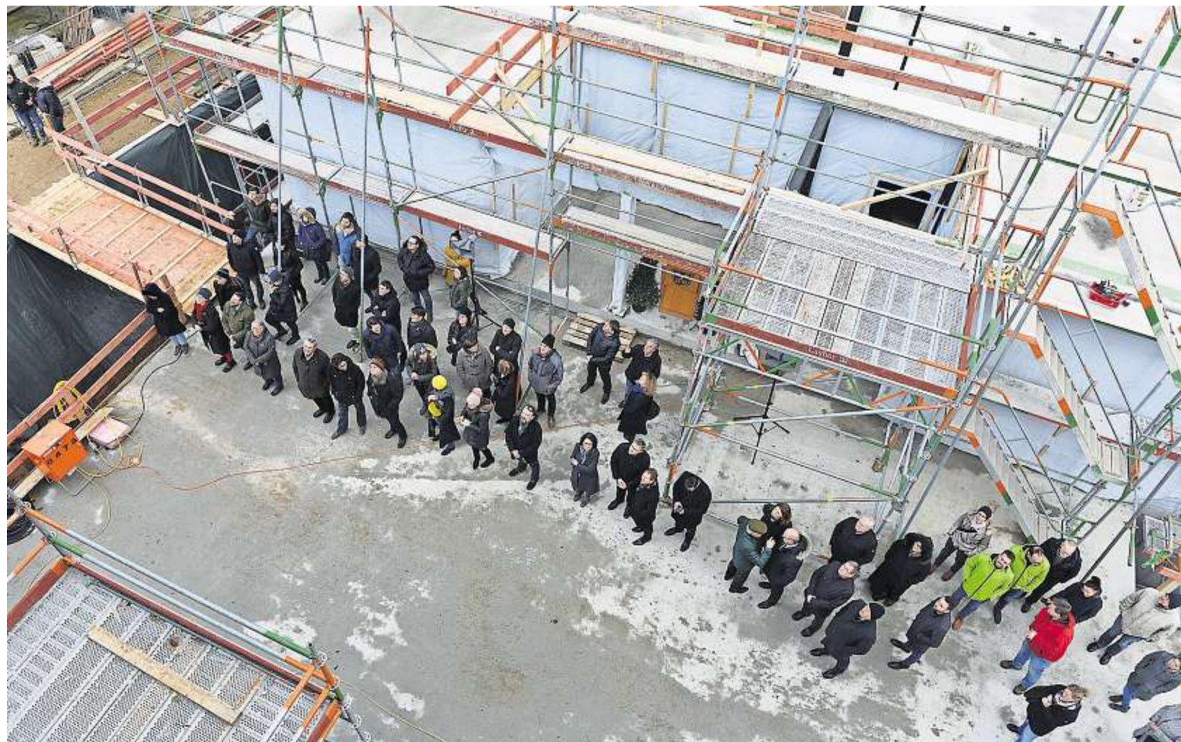
Trotz ungemütlichen Wetters herrschte bei den Bauherren Freude über den Fortschritt am RUBINA-Haus.
