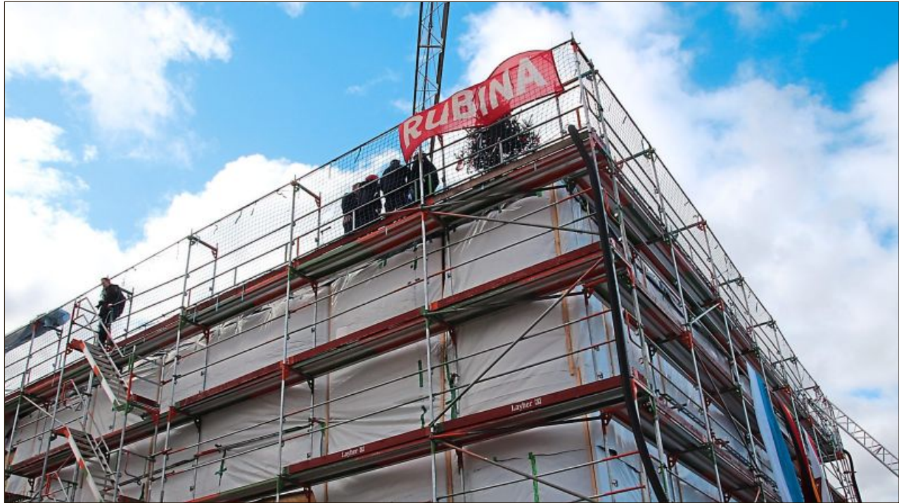
Der Rohbau des Multifunktionsgebäudes „Rubina“ ist fertig.
